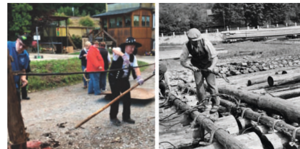
Das Wiedendreihen am Wiedstock war eine zeit- und kräfteaubende Arbeit. Die Wieden, zumeist in Ringen gebunden, wurden vor dem Einbinden der Flöße gewässert, damit sie wieder biegsam waren.
