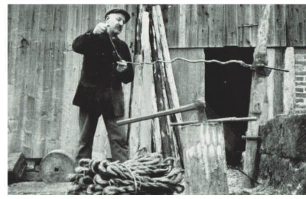
Das Wiedendreihen am Wiedstock war eine zeit- und kräfteaubende Arbeit. Die Wieden, zumeist in Ringen gebunden, wurden vor dem Einbinden der Flöße gewässert, damit sie wieder biegsam waren.
